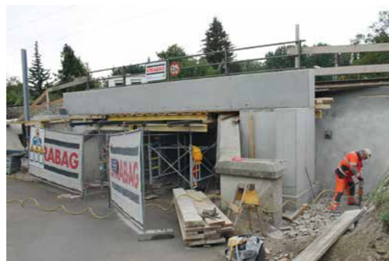
Im Zuge der Errichtung der Lärmschutzwand werden auch die Bahnunterführungen saniert
