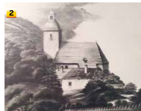
1 Der Turm (Abb. 1) wurde um 1830 aus statischen Gründen eingekürzt (Abb. 2), 1891 bekam er das heutige Aussehen (Abb. 3). 1896 wurde das an der Südseite angebaute Mesnerhaus samt Schule, Presshaus und Weinkeller abgerissen und durch Wochentagskapelle und Sakristei ersetzt, weiters die nord- und damit friedhofsseitigen Fenster zugemauert.
